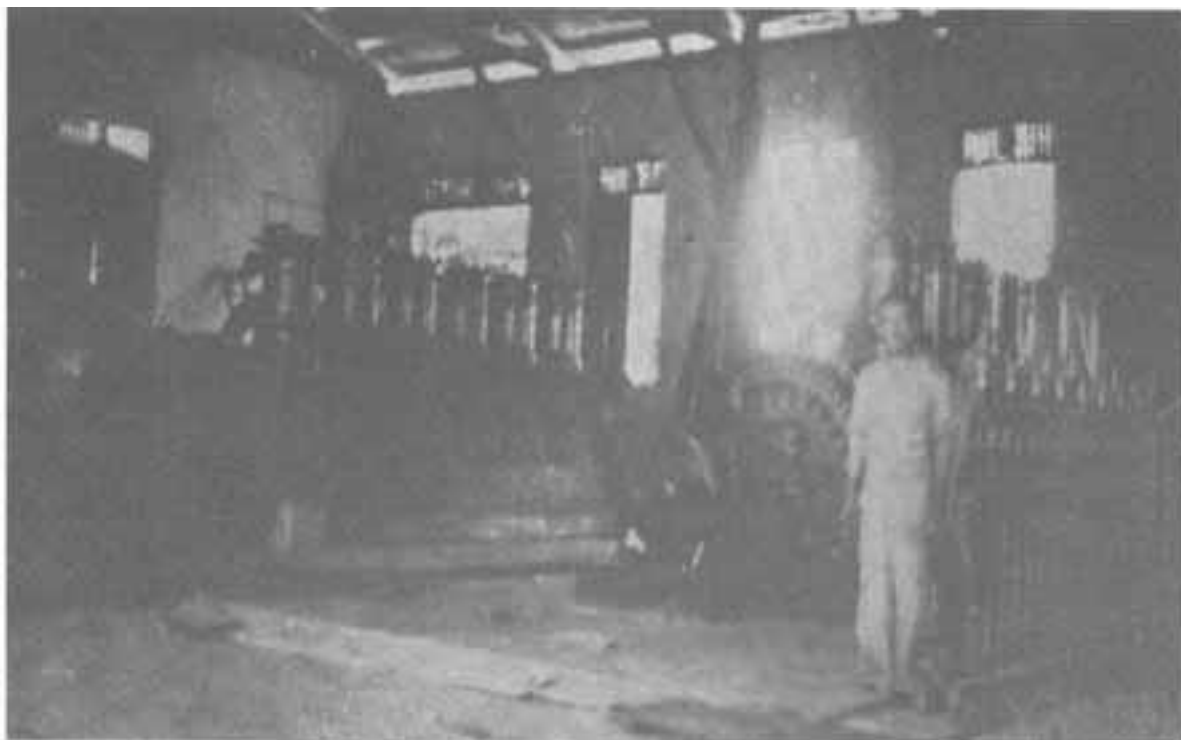
Interior de la planta eléctrica de Masaya. Fuente: Archivo General de La Nación .
